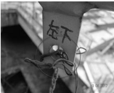
图3-7 左下销操作杆上的滑杆插孔
