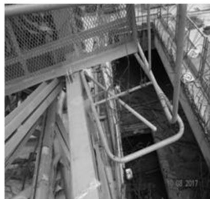
图3-12 左侧换步销轴操作杆的滑杆插孔
