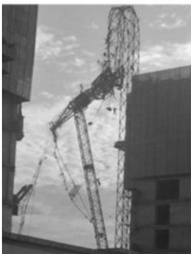
图 2-1 塔吊倾覆过程中上部宏观结构
