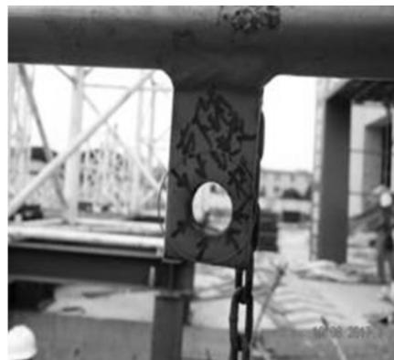
图3-8 右下销操作杆上的滑杆插孔
