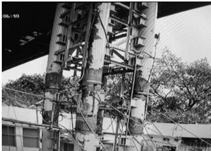
图9 钢管柱磁力管道切割机完成切割和挂钢丝绳
