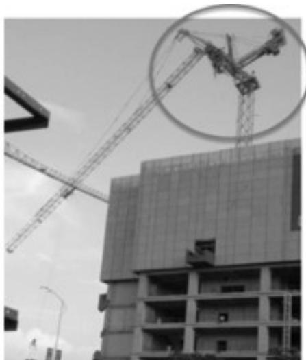
图 2-2 塔吊倾覆过程中结构宏观图
