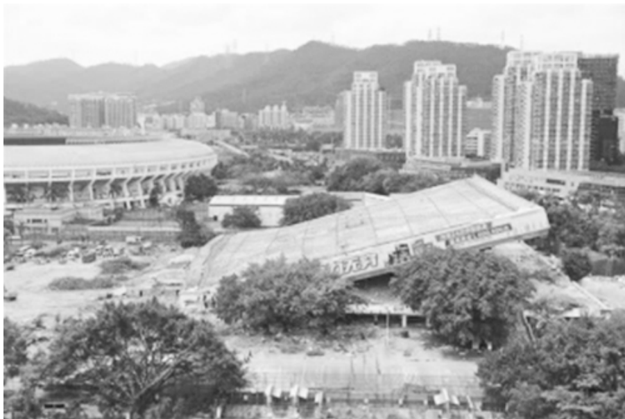
图 17 体育馆由西往东呈夹角状坍塌
