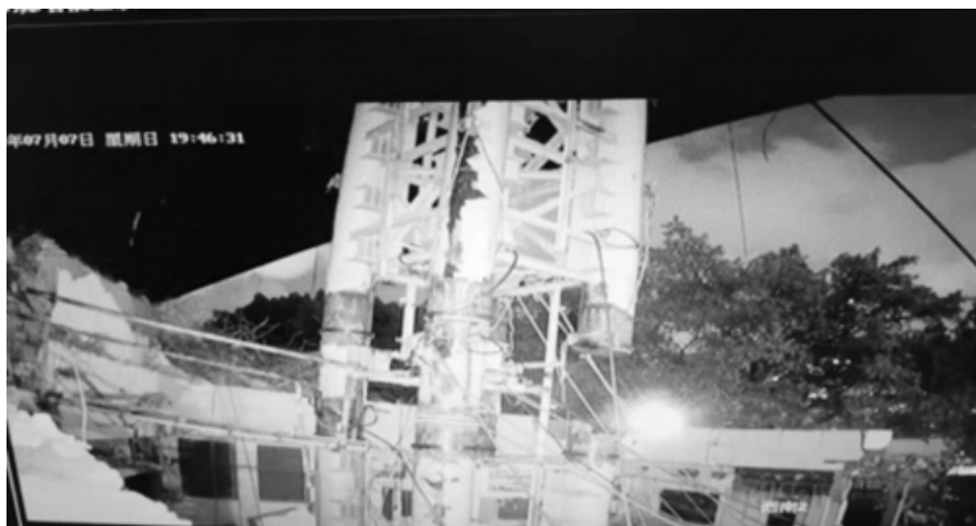
图 13 西南角格构柱的西南角 1 根钢管柱已全部拉出
