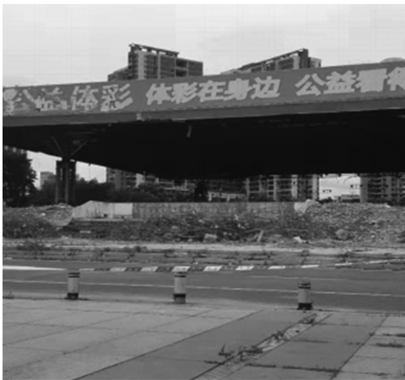
图5 拆除4.2米标高以上的混凝土结构
