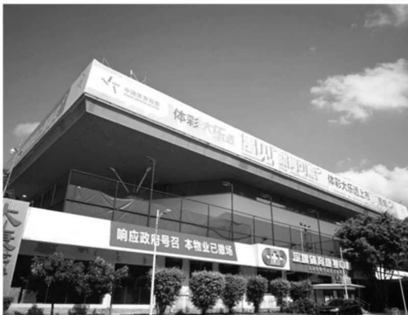
图1 深圳体育馆拆除前原貌
