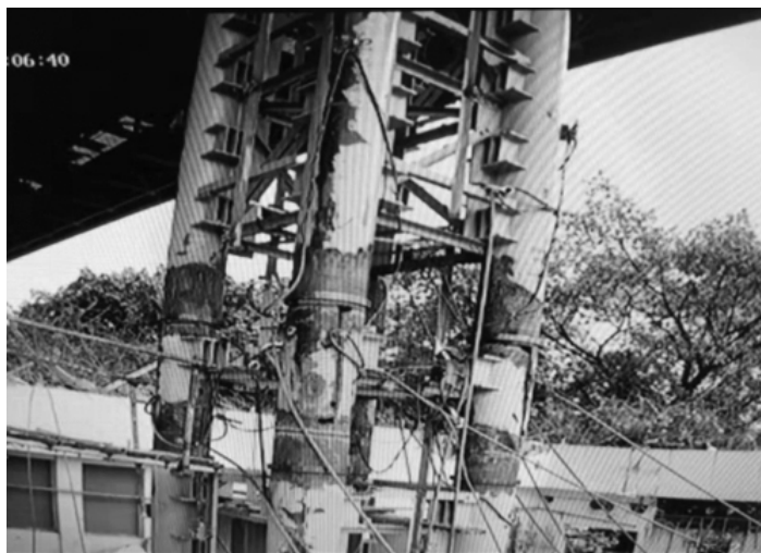
图9 钢管柱磁力管道切割机完成切割和挂钢丝绳
