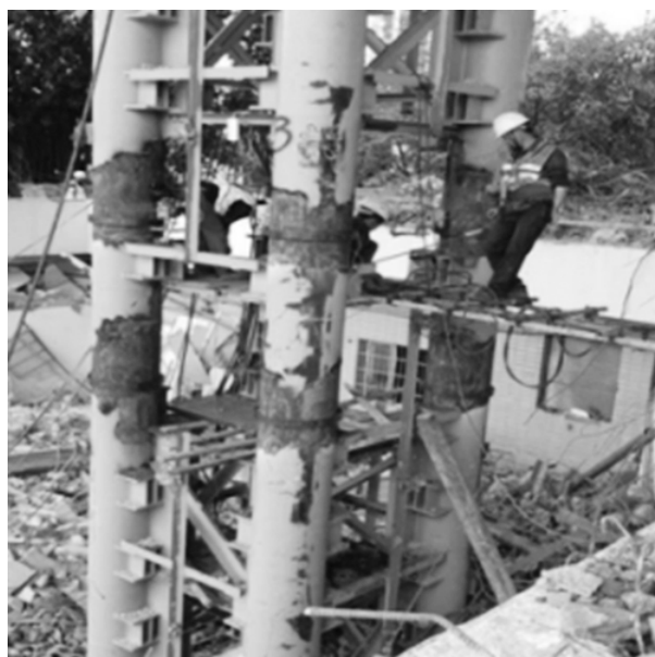
图6 西侧格构柱进行柱体打磨并安装磁力管道切割机导轨
