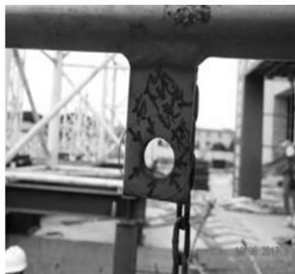
图 3-8 右下销操作杆上的滑杆插孔
