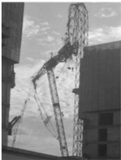
图 2-1 塔吊倾覆过程中上部宏观结构
