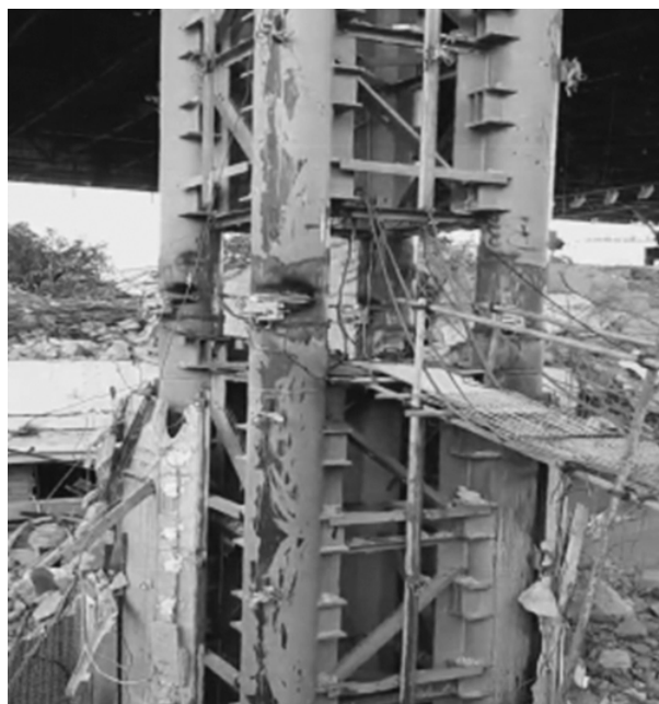
图7 东侧格构柱安装磁力管道切割机轨道
