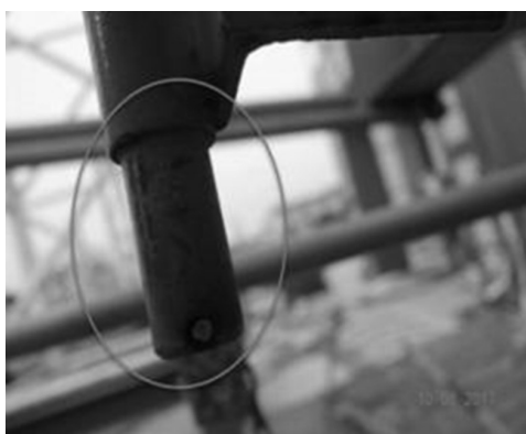
图 3-9 换步销操作滑杆安装支座
